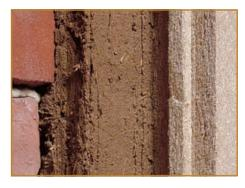
Die conluto-Holzfaserdämmplatte dient gleichzeitig als Putzträger für das conluto-Lehmputzsystem. Der gesamte offene Aufbau des Dämmsystems mit zusätzlichem Lehmputz erzielt eine optimale Feuchteaufnahme aus der Raumluft und schafft eine wunderbar angenehme warme Atmosphäre.
